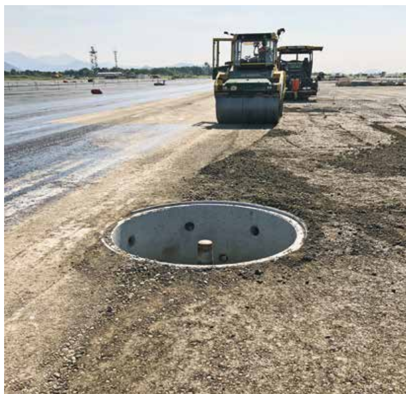
13. Le fasi di stesa e di compattazione del misto cementato
