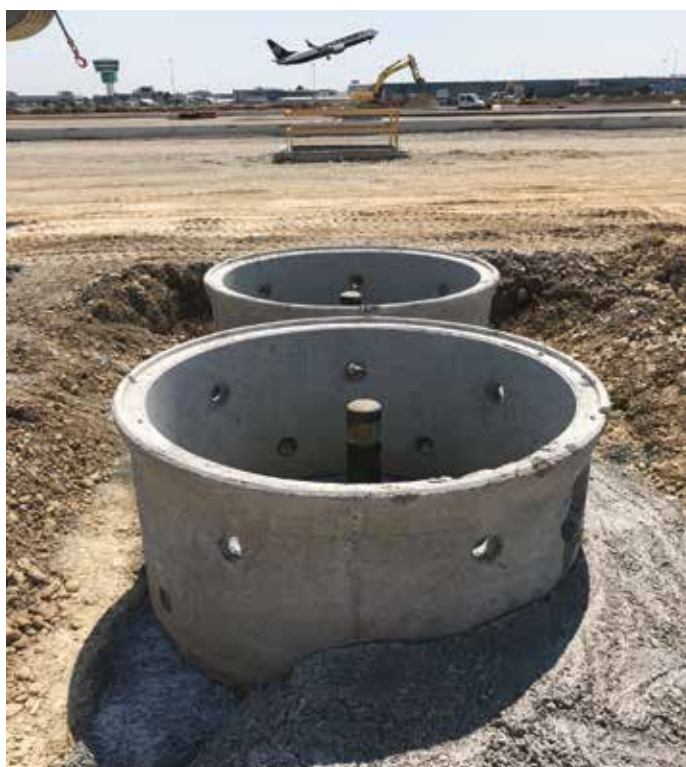
12. Il completamento dell'installazione del pit e il rinterro della linea HRS
