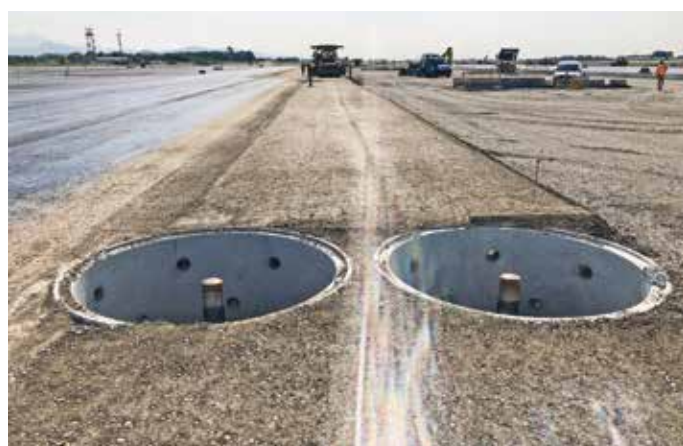
11. La stesa ultimata dello strato di misto cementato
