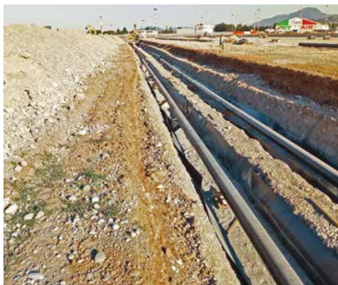
4. La posa delle tubazioni in acciaio e il rivestimento
