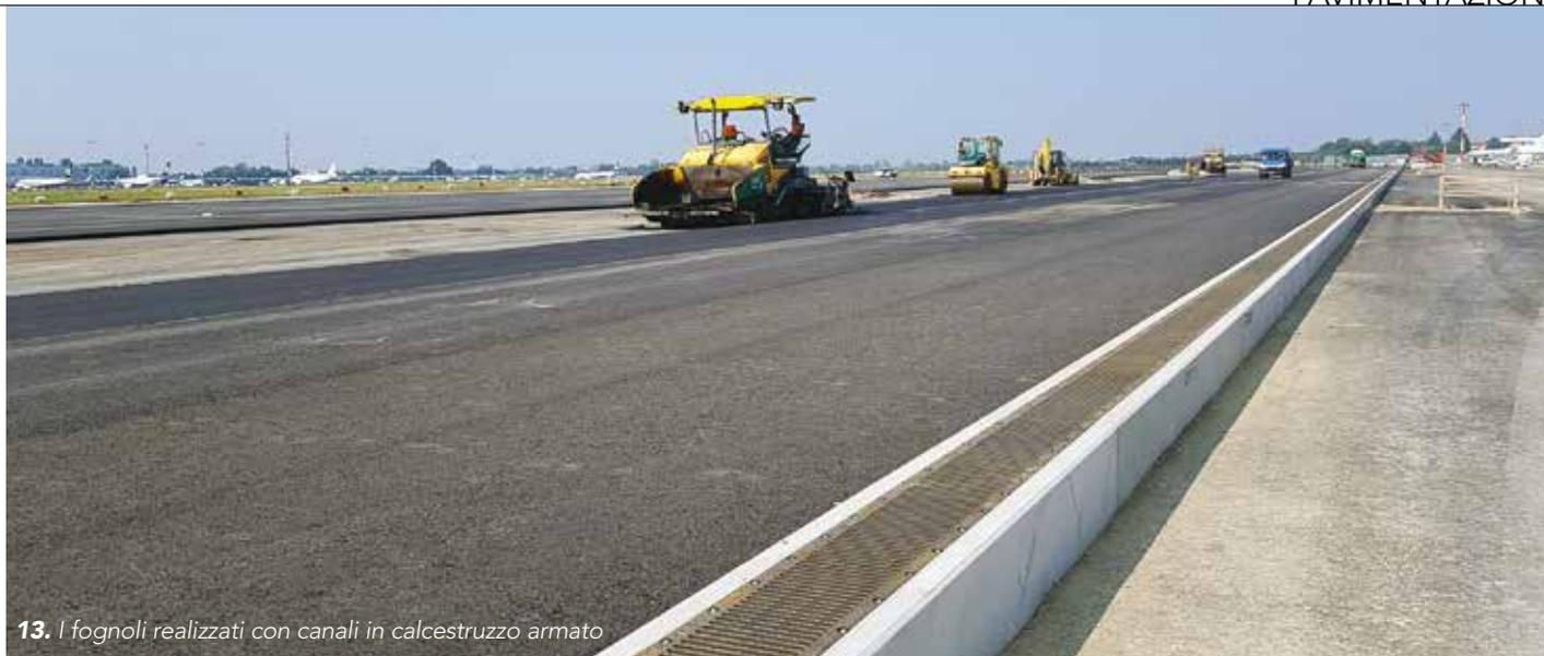
13. I fognoli realizzati con canali in calcestruzzo armato
