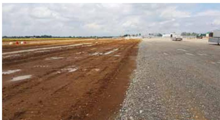
**4A e 4B.** Le fasi dedicate allo sbancamento del terreno esistente (4A) e alla rigenerazione del sottofondo (4B) si sono svolte tra Maggio e Giugno
