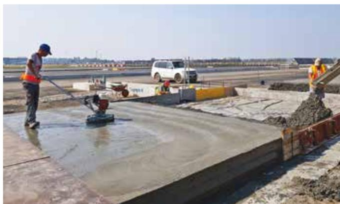
10A e 10B. Le fasi di lavorazione del lastronato con la Slipform
